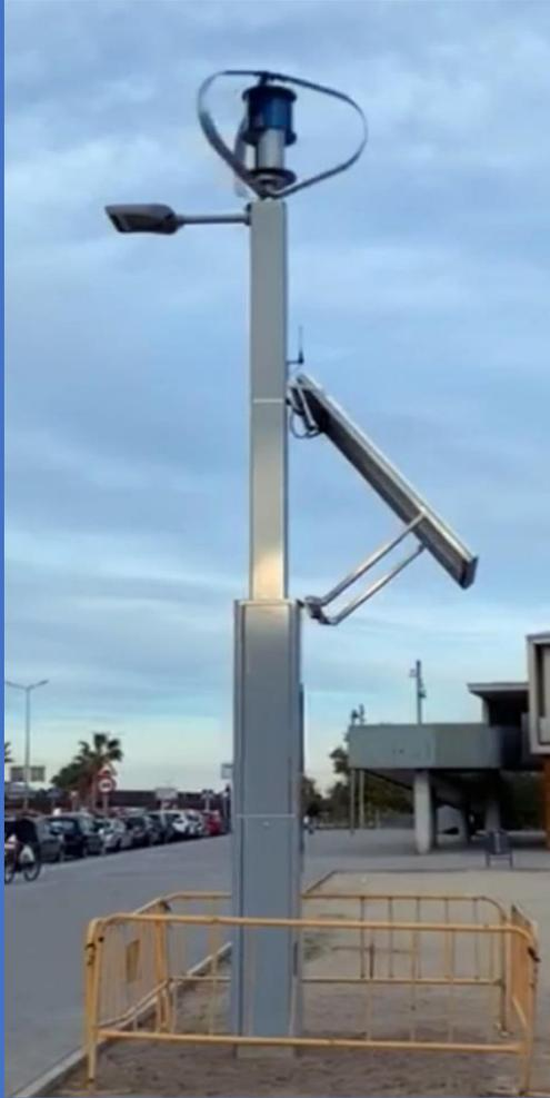
Des poteaux qui deviennent des conteneurs technologiques capables d'alimenter des lampes, des capteurs, des caméras vidéo.
